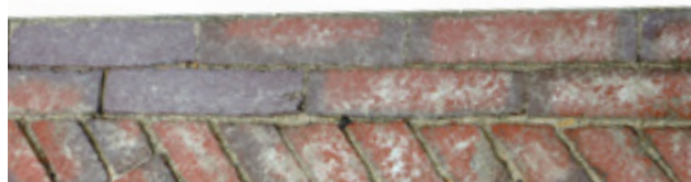
Abb. 174: Fassadenbordüre Klinker Doppelläufer.
