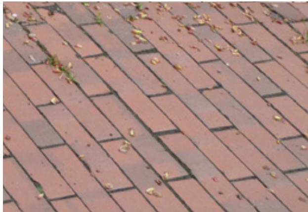
Abb. 150: Klinker, Reihenverband, hochkant.
