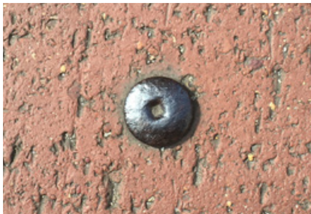
Abb. 193: Vermessungsnagel zur Begrenzung der Einzelhandelsfläche im Außenraum.
