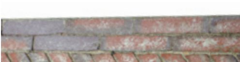
Abb. 36: Fassadenanschluss mit Klinker Doppelläufer.
