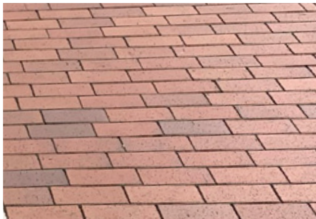
Abb. 113: Klinker, Reihenverband, flach, auf Gehwegen.
