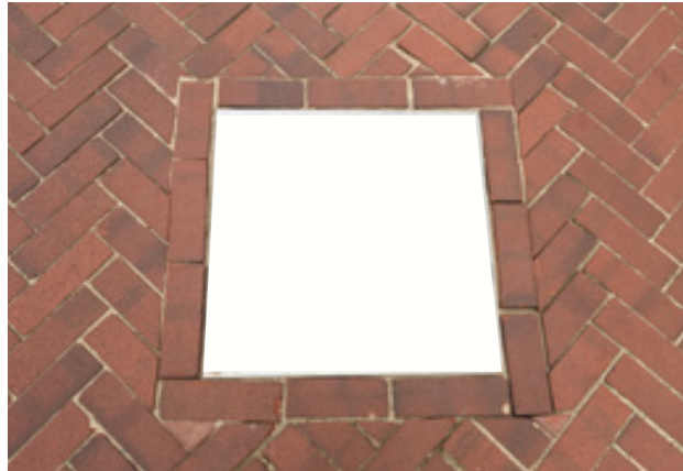
Abb. 159: Einbindung von Einbauten durch Klinkerläufer.
