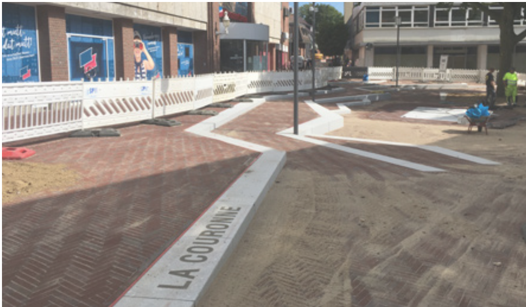
Abb. 11: Baustelle La-Couronne-Platz im September 2021.
