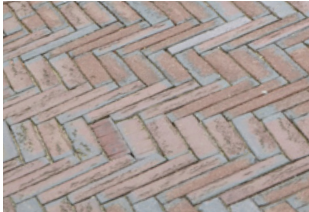
Abb. 173: Klinker, Fischgrätverband, hochkant.
