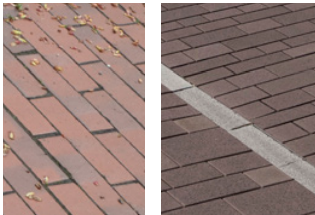
Abb. 181: Klinker, Reihenverband, hochkant, Einfassung Granitbord
