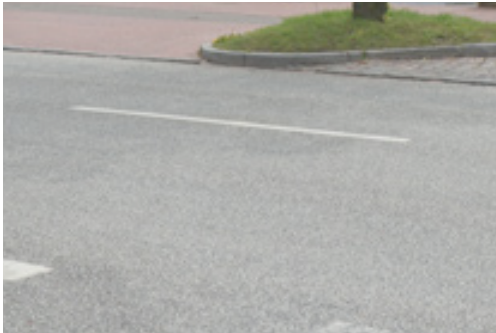
Abb. 30: Straßenbelag Asphalt in der Viktoriastraße.
