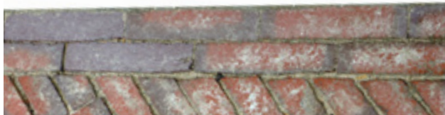
Abb. 112: Fassadenbordüre Klinker Doppelläufer.
