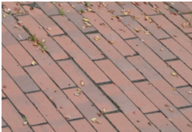
Abb. 111: Klinker, Reihenverband, hochkant, in den Parkbuchten und Überfahrten.
