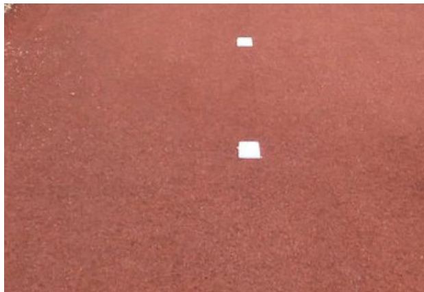
Abb. 110: Radweg im Gehweg, roter Asphalt.
