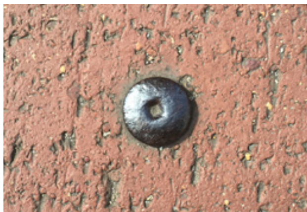
Abb. 161: Vermessungsnagel zur Begrenzung der Einzelhandelsfläche im Außenraum.
