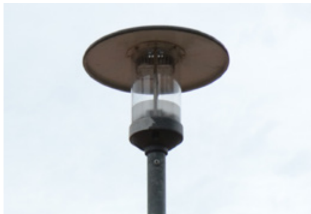
Abb. 116: Gehwegbeleuchtung Firma Schreder, Typ „Elite“, DB 703.
