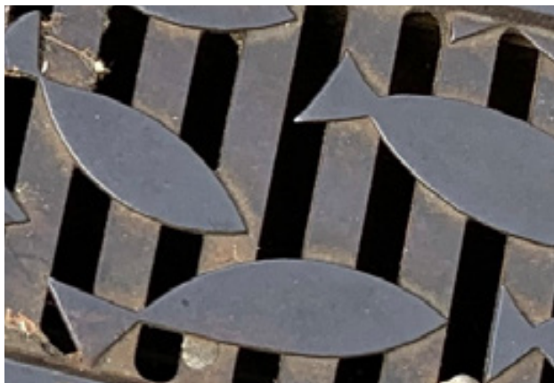
Abb. 146: Entwässerungsrinne aus Gusseisen (Motiv Stör).
