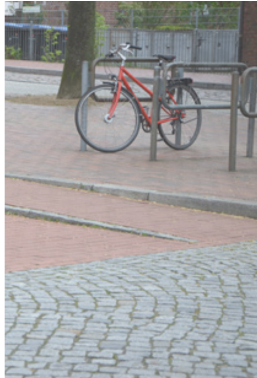
Abb. 77: Kopfsteinpflaster und Rampe auf dem Dithmarscher Platz.
