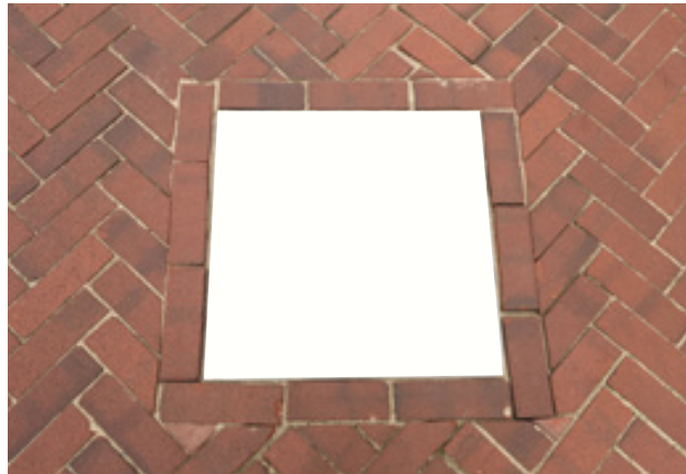
Abb. 191: Einbindung von Einbauten durch Klinkerläufer.
