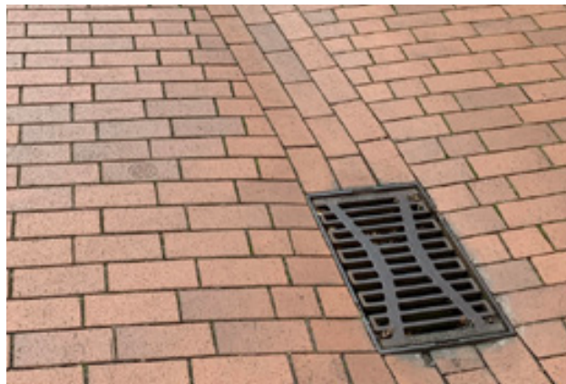
Abb. 175: Entwässerungsrinne aus Klinkerdreifachläufer.
